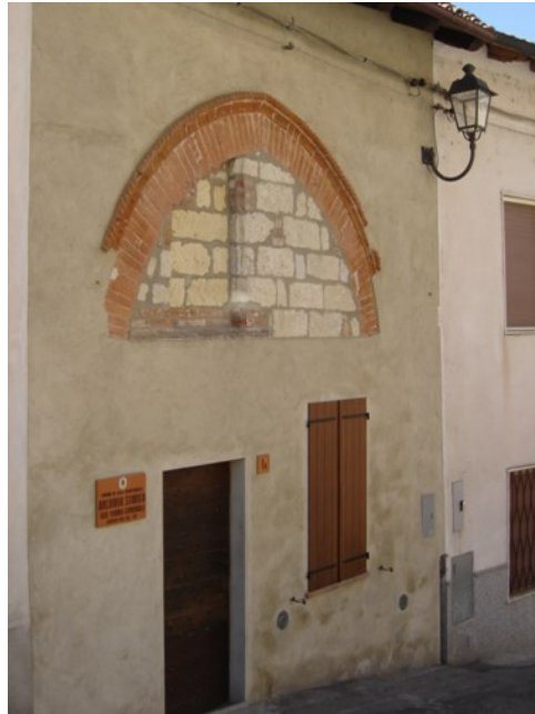
Centro storico – dettagli della muratura in tufo
